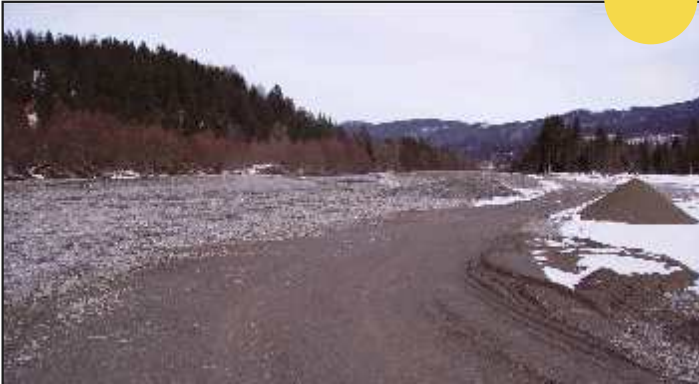
Massive Schotterentnahme aus dem Lechbett zwischen Letzener Brücke in Pflach und Lechaschauer Brücke im März 2009 zum Schutze der vom Hochwasser 2005 betroffenen Bevölkerung. Foto: Gemeinde Pflach
